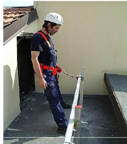
شکل ۴-۵۴ محدودکننده با اتصال یک ریل مخصوص
