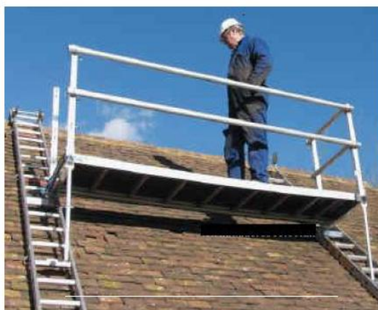
شکل ۳۰- جایگاه کار روی سطوح شیبدار
