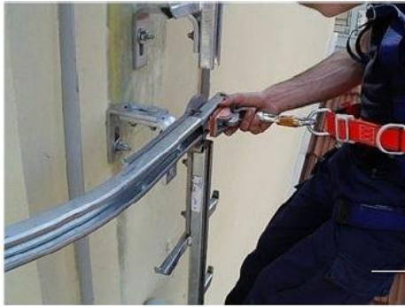
اشکال ۱۱۱- سامانه محدودکننده با استفاده از ریل
