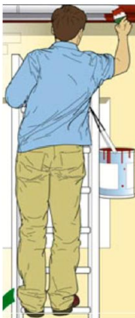
شکل ۱۳- نحوه استقرار صحیح برای کار
