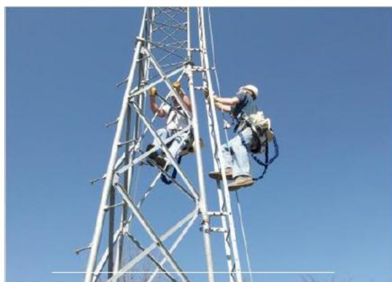
شکل ۷۴- صعود از نردبان با ابزار متوقف کننده
