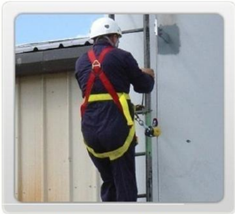
شکل ۷۶- صعود از نردبان با ابزار متوقف‌کننده
